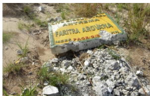
Destruction des panneaux le long de la RNT 19
