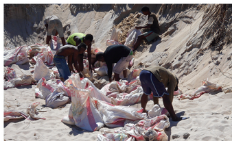
Remplissage des sacs avec du sable
